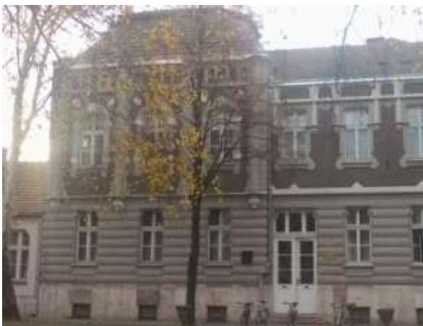
Zgrada Odeljenje u Novom Bečeju
