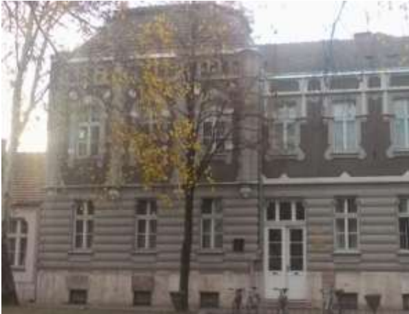
Zgrada Odeljenje u Novom Bečeju
